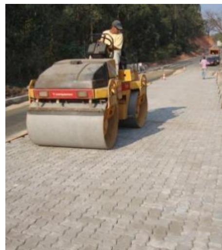
Figura 08: Compactação do intertravado após assentado.
